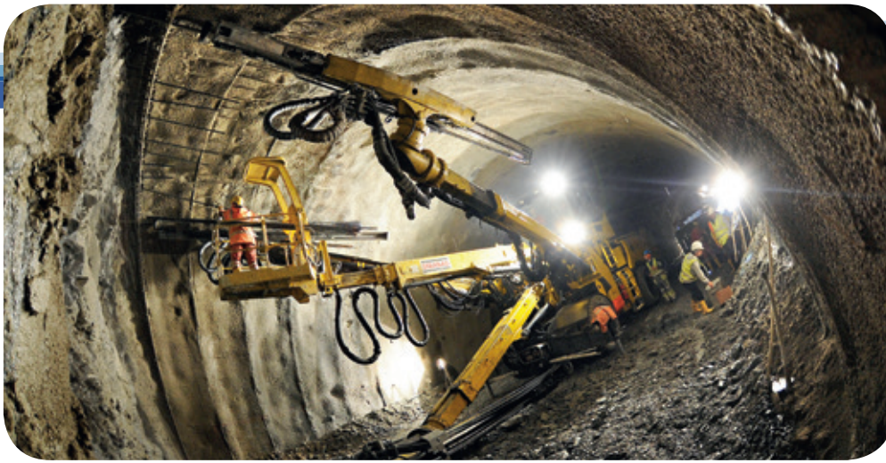
Sicherung des Tunnelgewölbes mit Spritzbeton, Anker, Gitterbögen und Baustahlmatten.
