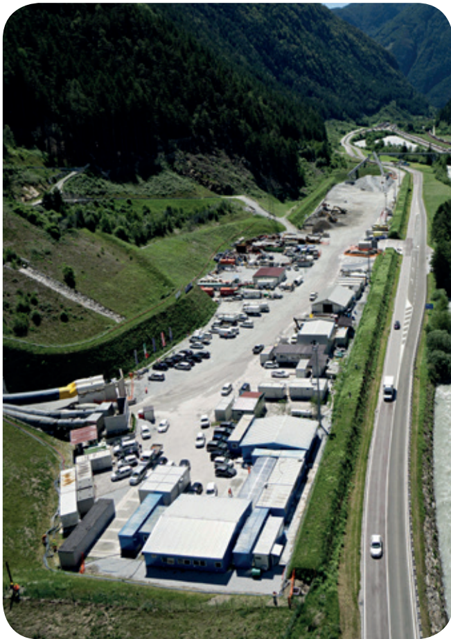
Am Baustellenareal bei Mauls werden die Umwelt- und Emissionsschutz-Maßnahmen sichtbar.
