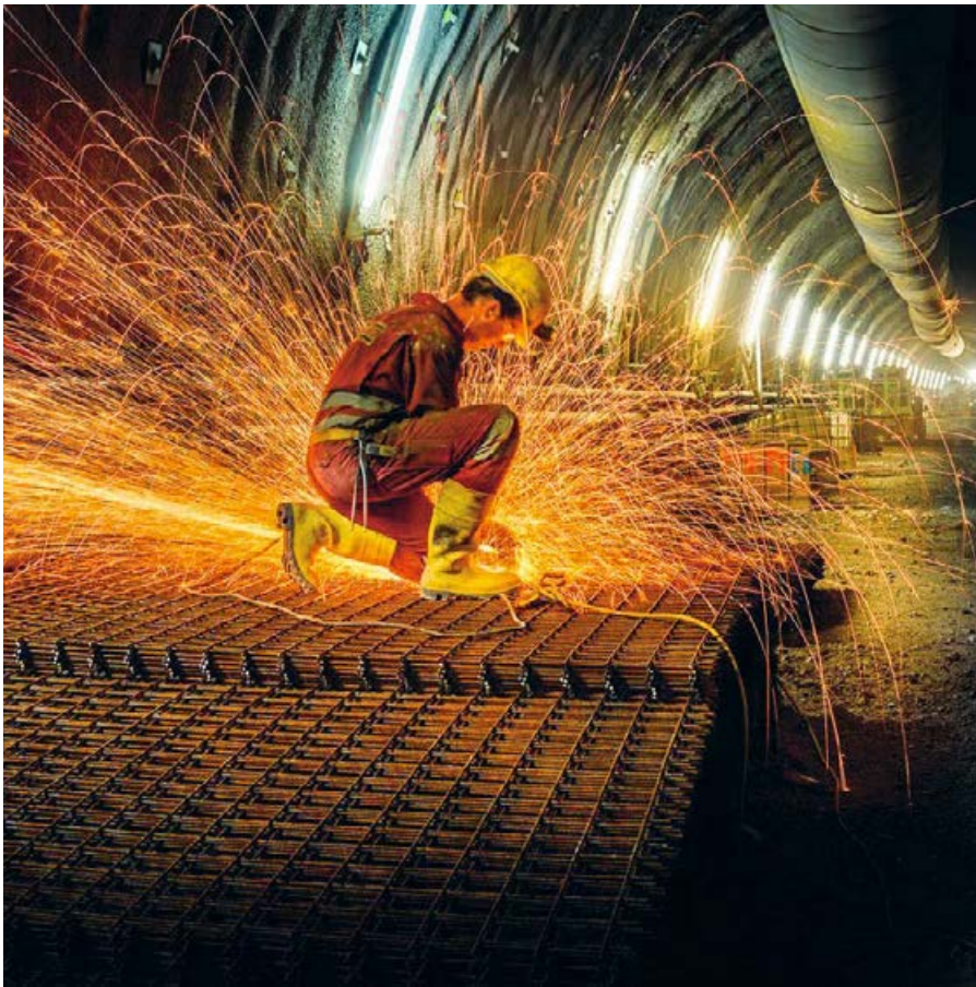
BAUARBEITEN. Die zwei Tunnelprojekte auf der Südstrecke gehen wie geplant voran
