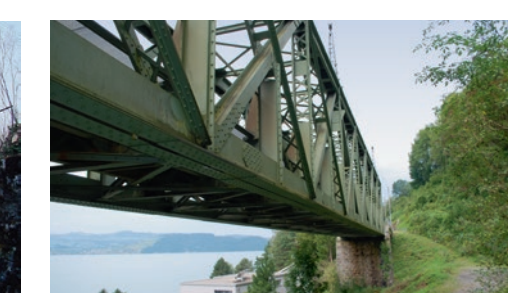
↑ Erneuerung Rostschutz Stahlbrücke.
