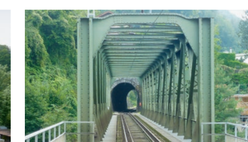
↑ Unterhalt Brücke Tunnel Trasse.
