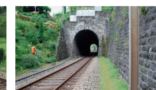
↑ Sanierung und Profilerweiterung Tunnel.
