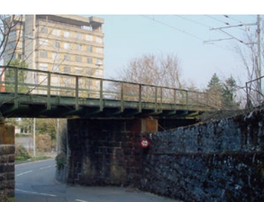
↑ Ersatz Stahlbrücke durch Betonkonstruktion.
