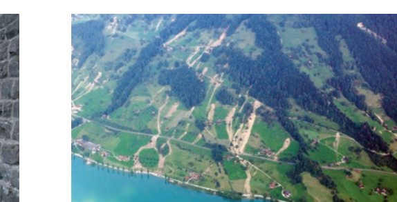
↑ Sicherheitsmassnahmen gegen Hangmuren und Steinschlag.
