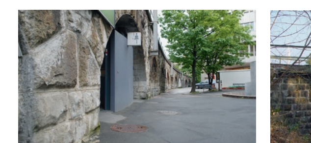
↑ Neuer Betontrög und Sanierung Naturstein-Mauerwerk Stadtviadukt.
