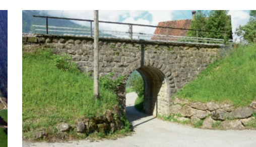
↑ Instandsetzung Wände und neuer Betontrög Wegunterführung.
