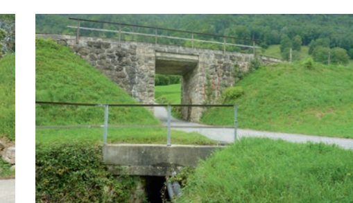
↑ Aufweitung Strassenunterführung und Bachdurchlass.
