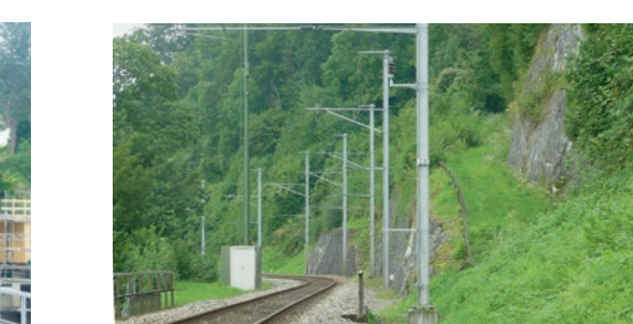
↑ Hangabtrag und Stützmassnahmen Doppelspur.
