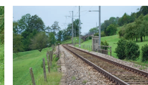
↑ Kompletterneuerung Bahnunterbau, Schotter, Schienen, Schwellen.
