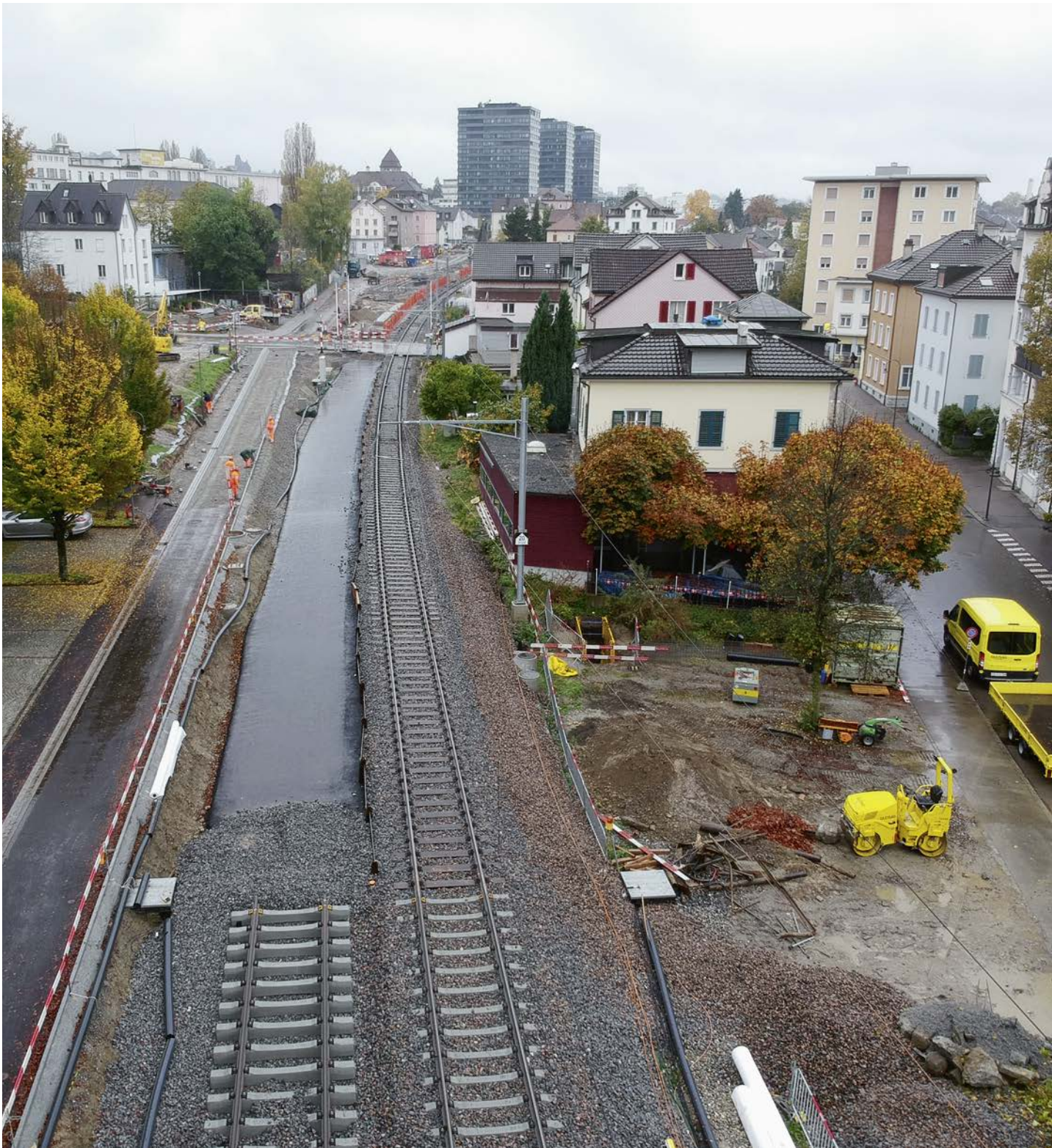
HGV-A, Doppelspurausbau Goldach-Rorschach Stadt.
