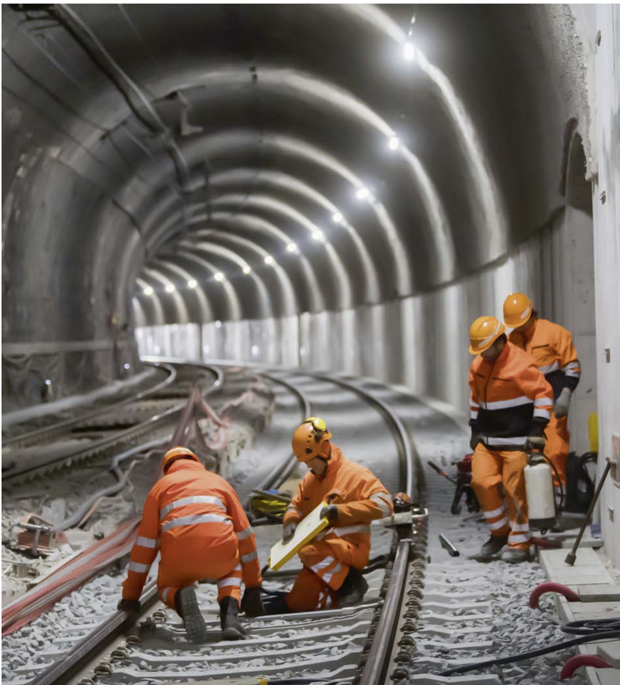
4-Meter-Korridor, Profilerweiterung Paradiso-Tunnel.
