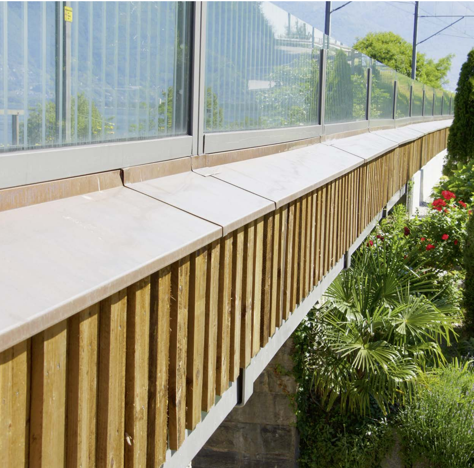
Lärmschutzwand San Nazarro.
