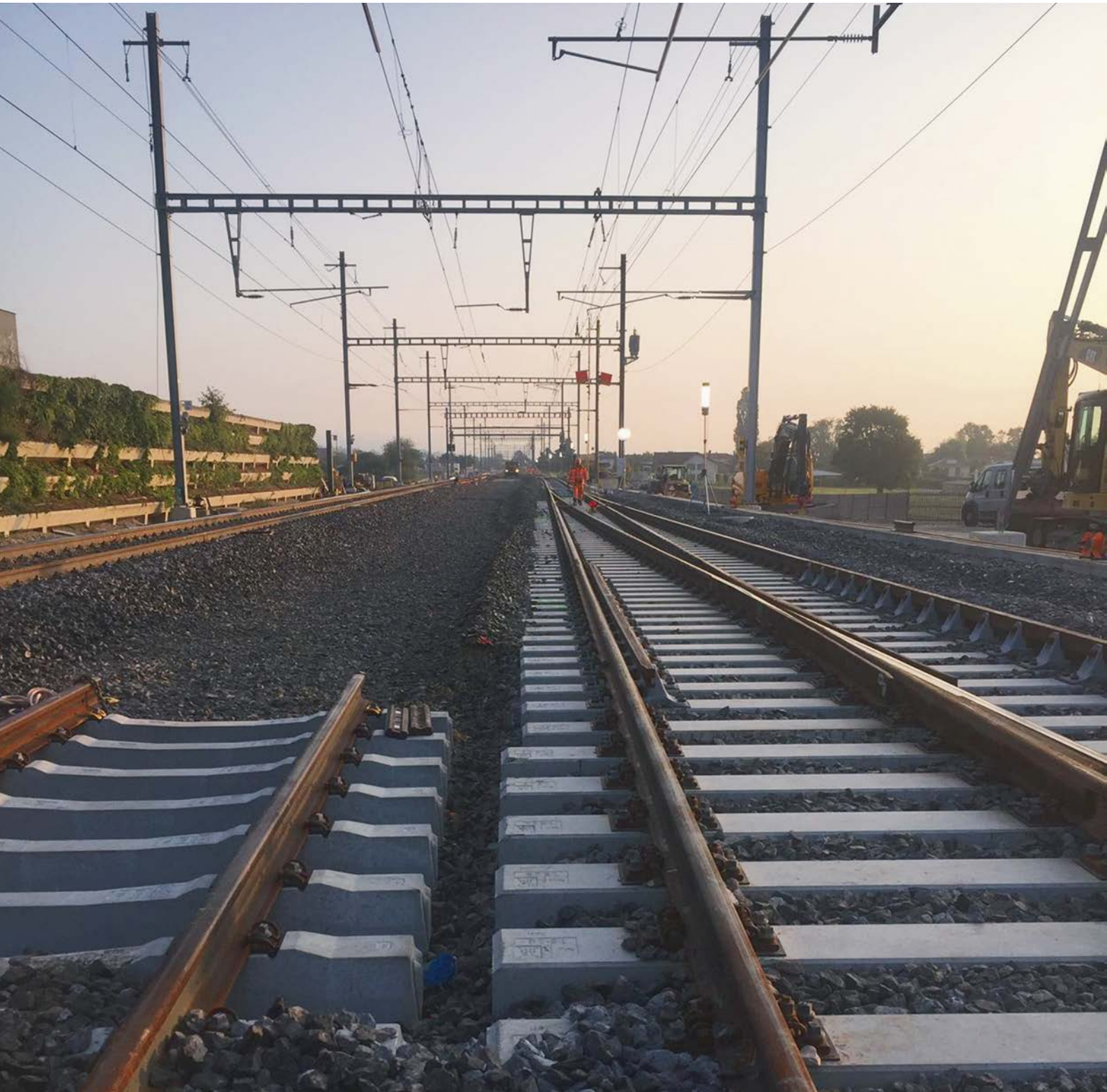
AS25, Bau Überholgleis Coppet-Founex abends.
