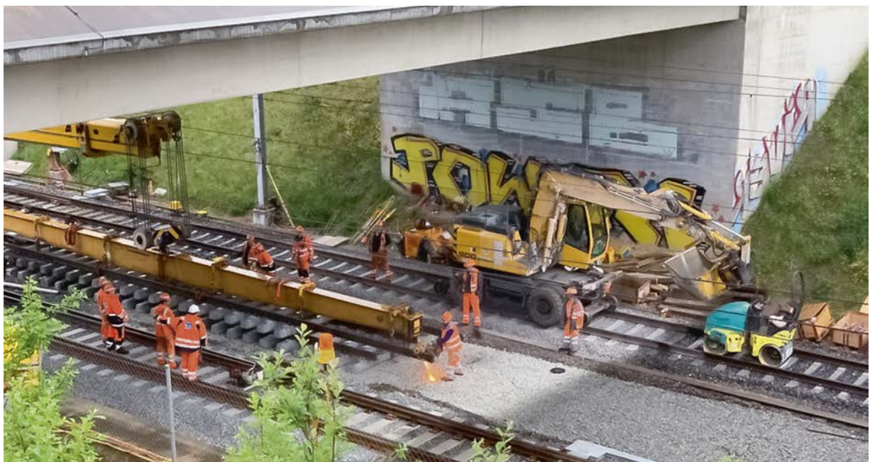
Fahrbahnarbeiten in Gexi.
