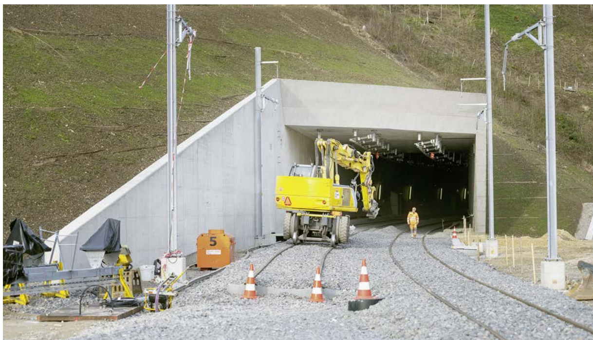
4mK Bötzingen, gleisgebundene Bauarbeiten im Tunnel.
